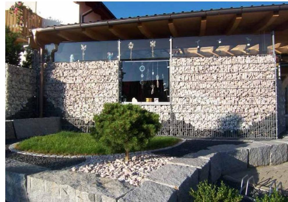
отмостку здания или асфальт. Стойки бетонируют в грунт, хотя в некоторых случаях можно обойтись и без фундамента, поэтому вся работа не займет более одного дня.
